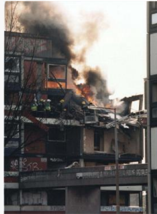
国外某居民楼煤气爆炸
